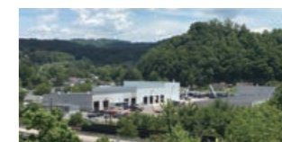
生産拠点:タダノ・マンティス Corp.(米国)
