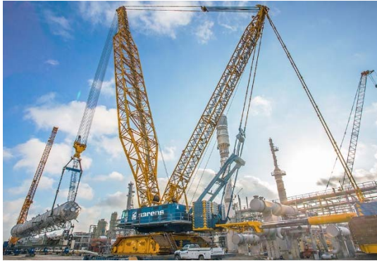
大型プラント建設工事を行うCC 8800-1
