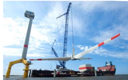
洋上で風車のブレード据付を行うクローラークレーン
