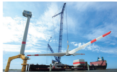
港湾での風力発電設備組み立て
