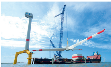
港湾での設備組み立て
