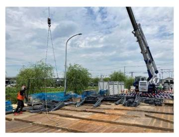
移動式クレーン遠隔操作システム「CRANET」とは、移動式クレーンの運転席とその周囲に設置された複数台のカメラによって撮影された映像を通常のインターネット通信網を経由して離れた場所にあるコックピットへリアルタイムに送信し、専用のモニターへ映し出します。コックピットは実際の運転席の環境を忠実に再現し、荷重などの動作信号に加え異常信号を監視する専用モニターも配置することで、作業現場に設置した実際の移動式クレーンの運転席と遜色がない作業環境で、レバー・スイッチから送られる信号を遠隔の実機に伝え、実際のクレーン操作が可能になるというものです。
