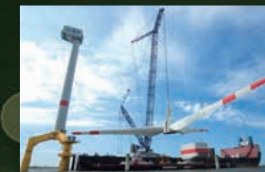
港湾での風力発電設備組み立て
