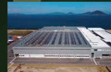
太陽光パネルの設置 (香西工場)
