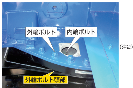
旋回ベアリング取付けボルト点検用窓
