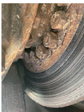
ディスクプレート腐食
