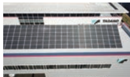
太陽光パネルの設置(技術研究所)
