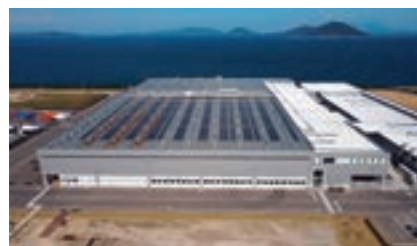
太陽光パネルの設置(香西工場)
