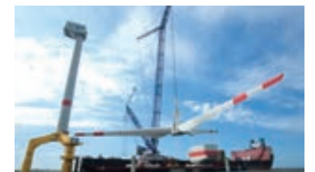
港湾での風力発電設備組み立て
