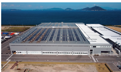
太陽光パネルの設置(香西工場)
