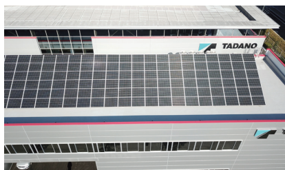
太陽光パネルの設置(技術研究所)
