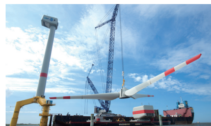
港での風力発電設備組み立て
