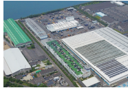
太陽光パネルの設置 (志度工場)
