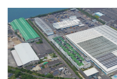
太陽光パネルの設置(志度工場)
