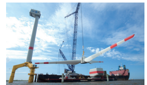
港湾での風力発電設備組み立て
