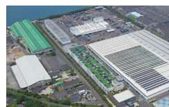
太陽光パネルの設置 (志度工場)
