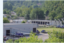
Tadano Mantis Corporation 工場
