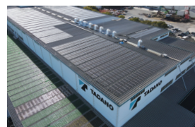
太陽光パネルの設置(多度津工場)
