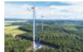
風力発電設備組み立て
