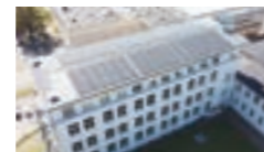
太陽光パネルの設置 (Dinglerstraße事務所)
